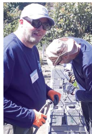
Betonijzer vlechten in Guatemala
